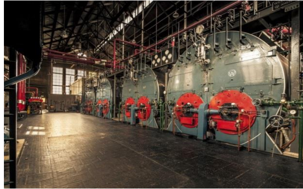
Foto boven: stoomketels in ketelhuis Ir. Woudagemaal te Lemmer
